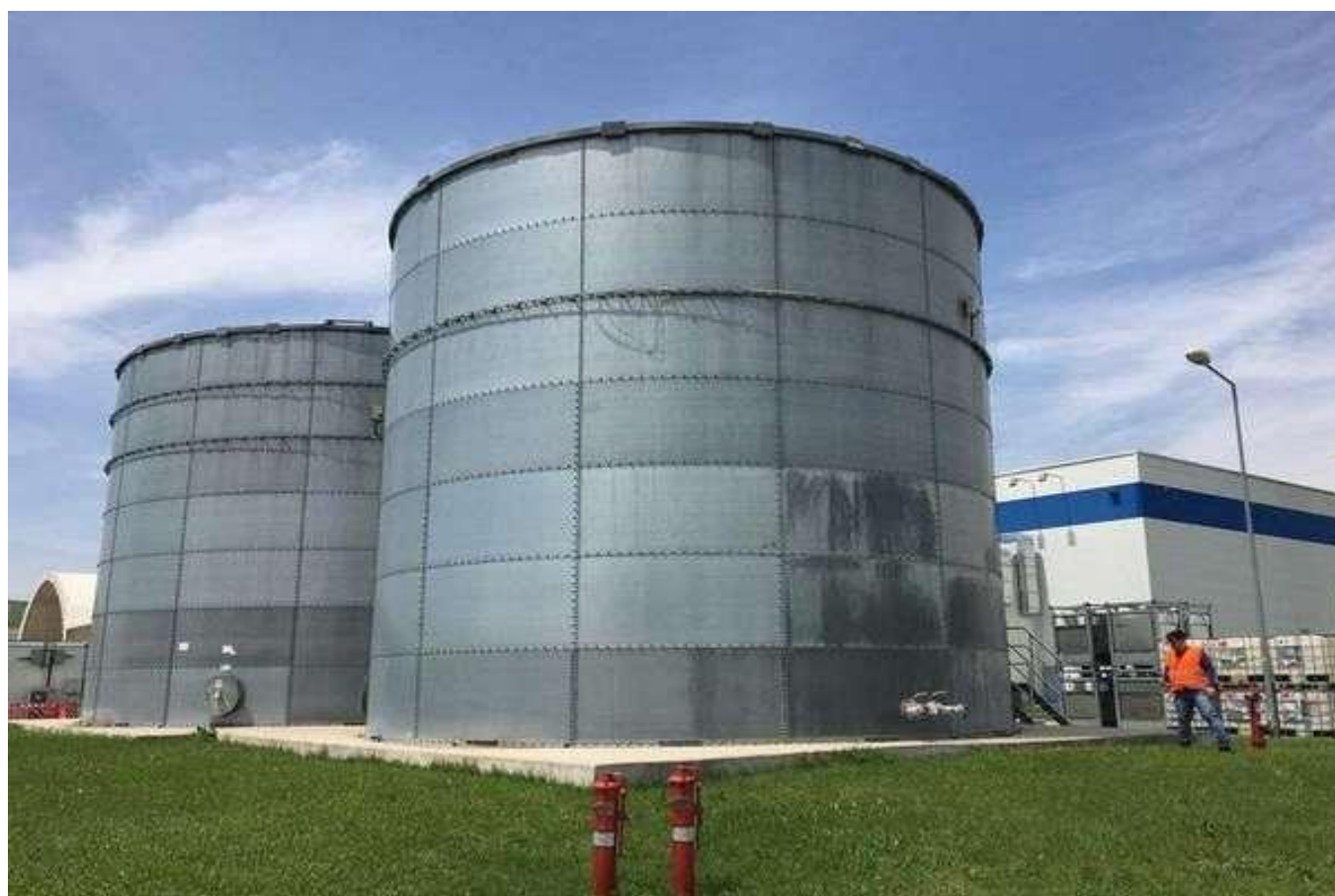
Rezervor de apă potabilă
