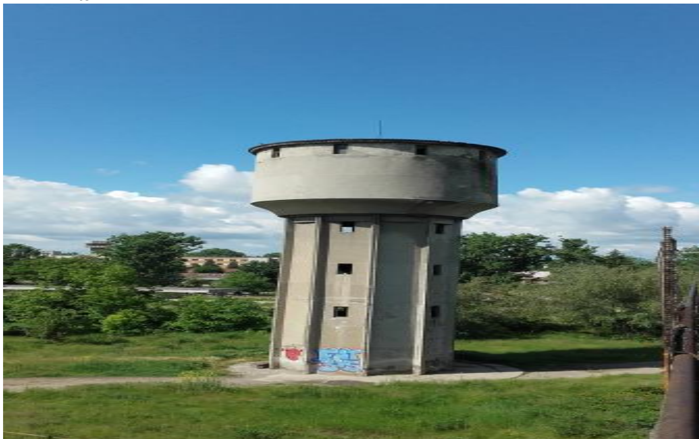
Castel de apă
