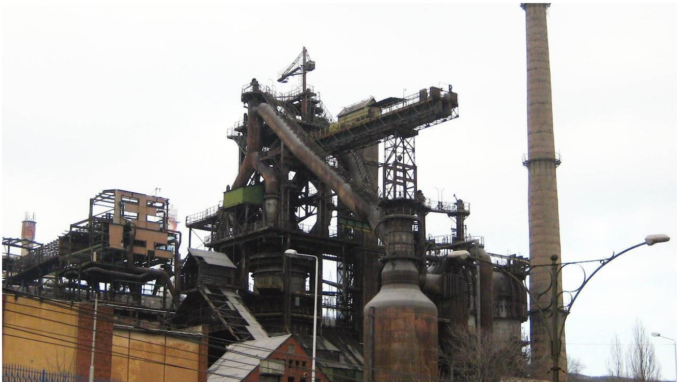
Fig.2. Furnalul numărul 2 de la Reșița, județul Caraș Severin declarat ca monument istoric de arhitectură industrială din 2003
